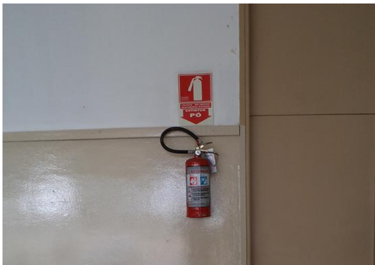
Figura 19 - Extintor devidamente instalado e sinalizado Fonte: Arquivo pessoal
