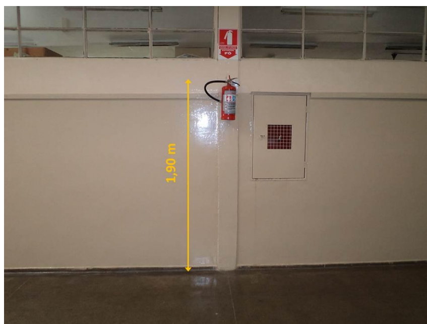
Figura 15 - Altura do extintor no andar superior Fonte: Arquivo pessoal
