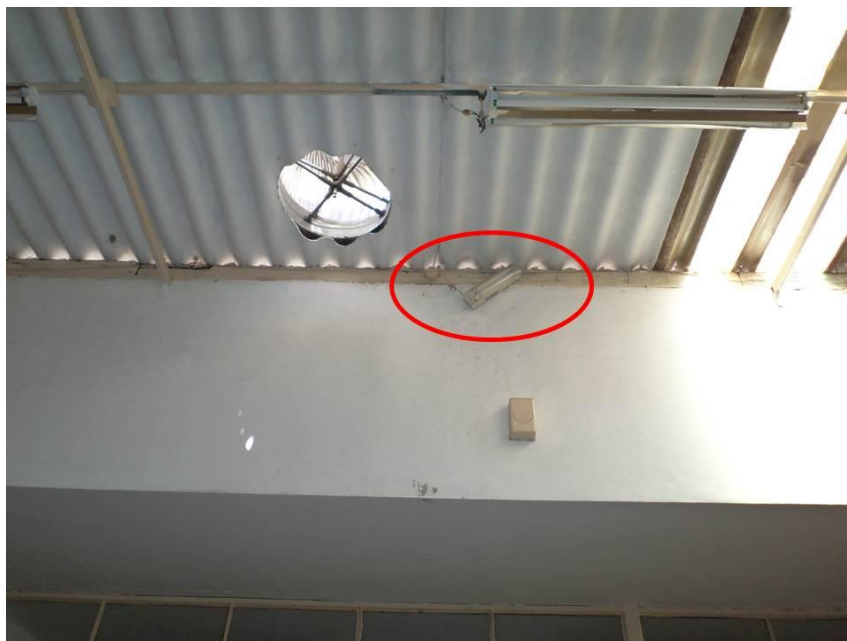
Figura 23 - Lâmpada de Emergência no andar superior Fonte: Arquivo pessoal
