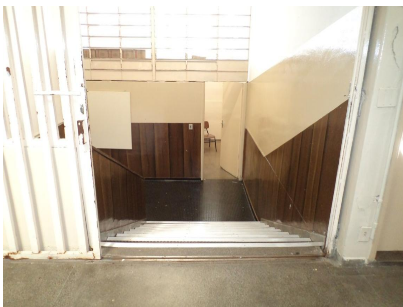
Figura 26 – Escada sem corrimão Fonte: Arquivo pessoal
