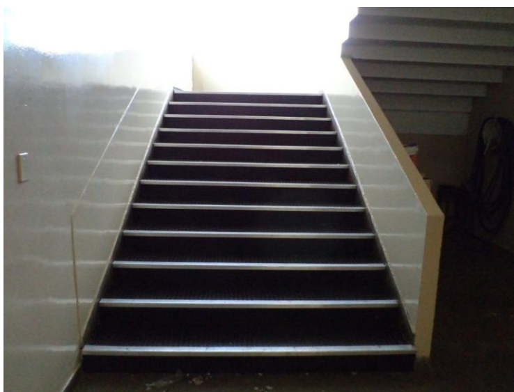
Figura 25 – Escada sem corrimão Fonte: Arquivo pessoal
