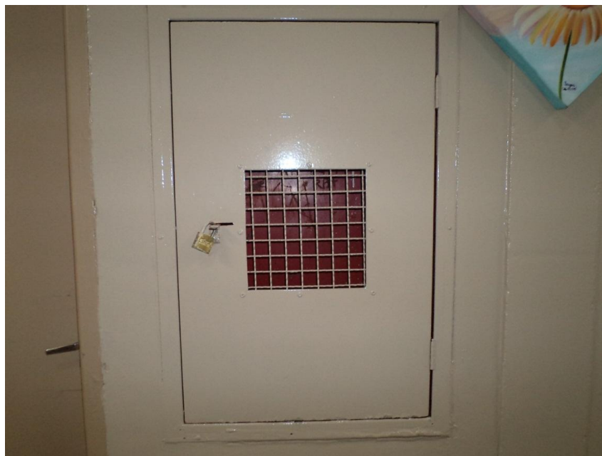
Figura 17 - Abrigo de hidrante trancado Fonte: Arquivo pessoal
