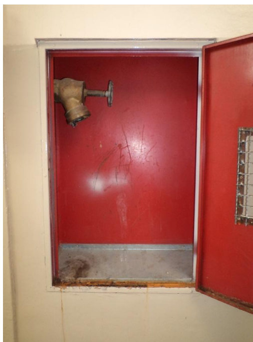
Figura 18 - Hidrante sem mangueira Fonte: Arquivo pessoal
